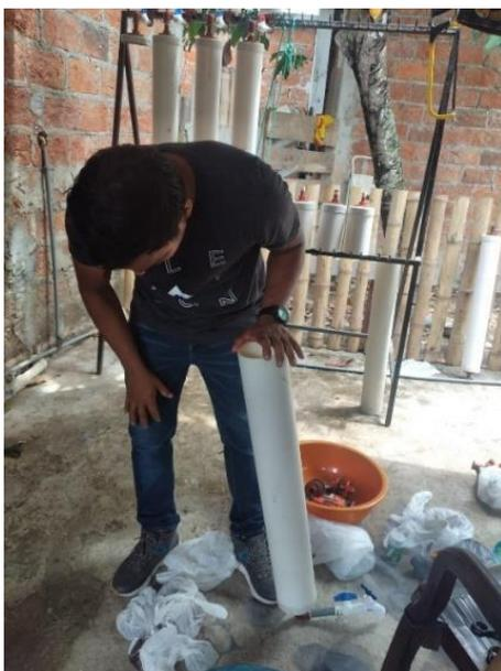
**Foto 13.** Unión del tubo PVC con un codo de media pulgada más 10 cm de tubo de agua con la llave de paso
