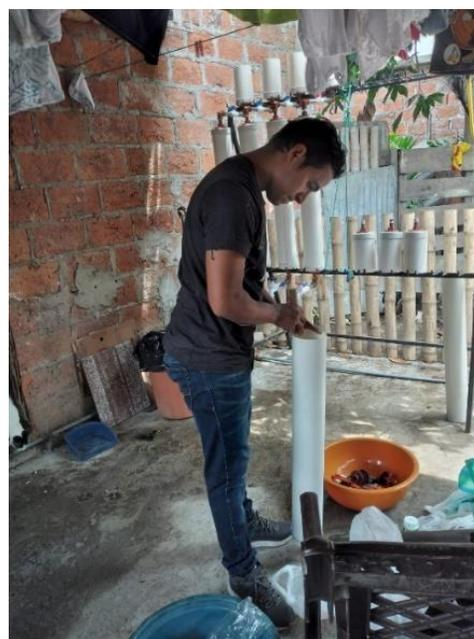
**Foto 10.** Llenado del tubo PVC con material orgánico (fibra de coco recortada y fibra en polvo)
