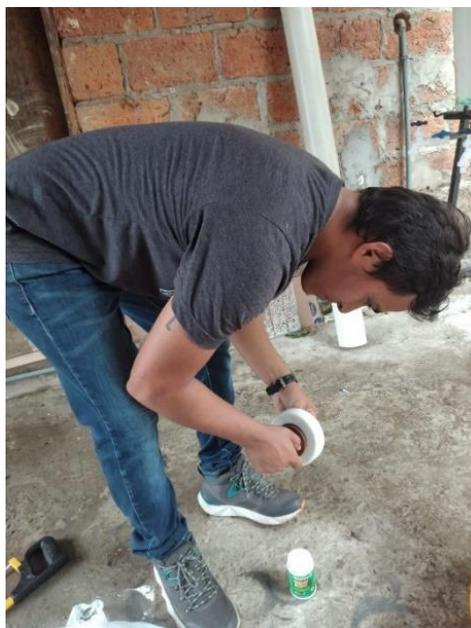
**Foto 9.** Unión de adaptador de media pulgada a una tapa ciega o tapa macho
