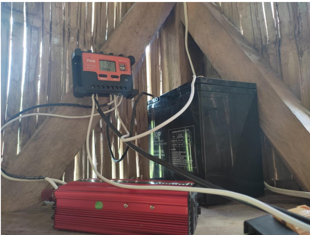
Anexo 8E. Instalación de los equipos del sistema fotovoltaico
