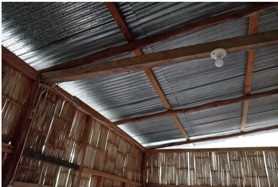
Anexo 8D. Instalación del cableado eléctrico interno
