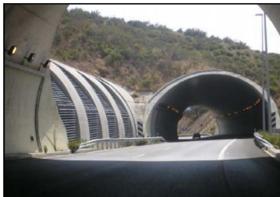
Figura 2.2. Falso túnel. Autovía jerez – Los Barrios. Cádiz Fuente: Nerea Aizpurúa, 2010
