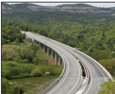
Figura 2.4. Viaducto de Osormort, Parc del Montsen Fuente: (Arqued, 2020).
