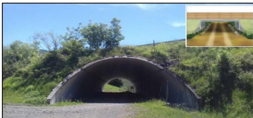
Figura 2.6. Paso interior mixto en la autovía de la meseta, Cantabria Fuente: (Ruiz, 2017)
